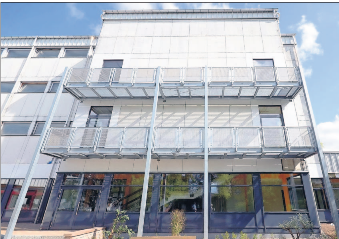
Fluchtbalkone, deren Türen sich im Notfall automatisch öffnen, ermöglichen bei einem Feuer die schnelle Flucht aller Schüler aus dem verrauchten Gebäude. FOTO: BUCHHOLZ
