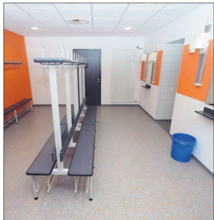
Die Umkleieräume mussten ebenso wie die Toiletten komplett neu gebaut werden. In den alten Räumen drohten die Wände einzustürzen. FOTO: BUCHHOLZ
