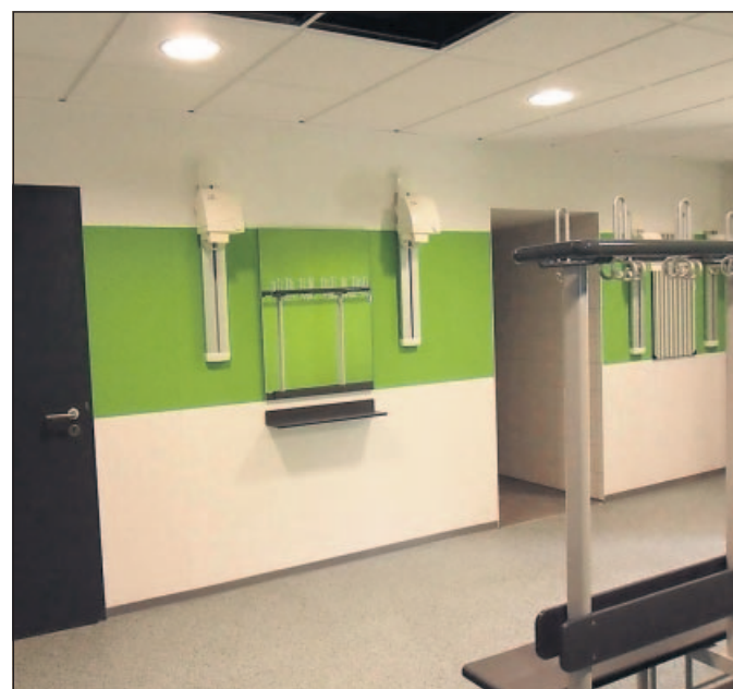
Auch die Umkleideräume wurden energetisch saniert. Außerdem sind jetzt Vereine und Schüler getrennt. FOTO: PRIVAT
