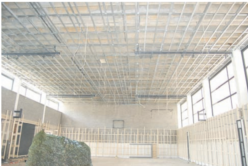
Die Turnhalle sieht momentan mehr nach Großbaustelle aus.
