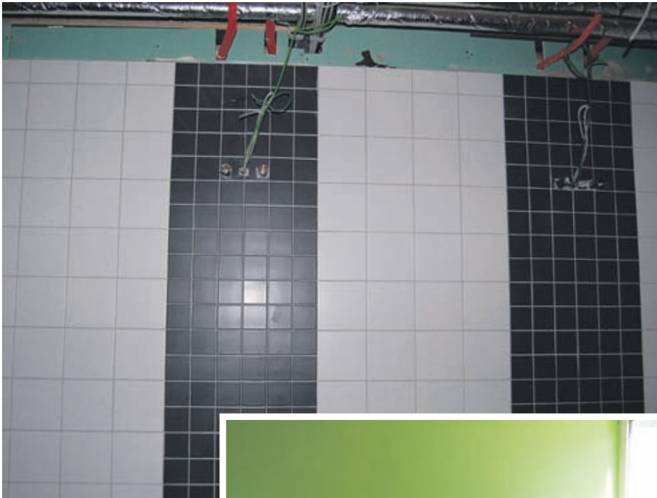
Die Sanitärräume werden zukunftsfit gemacht.
