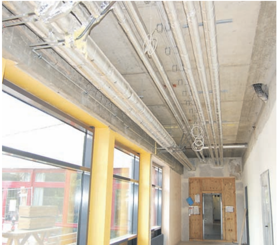
Noch lässt der Rohbau tiefe Blicke ins Innenleben des „Kant“ zu.
